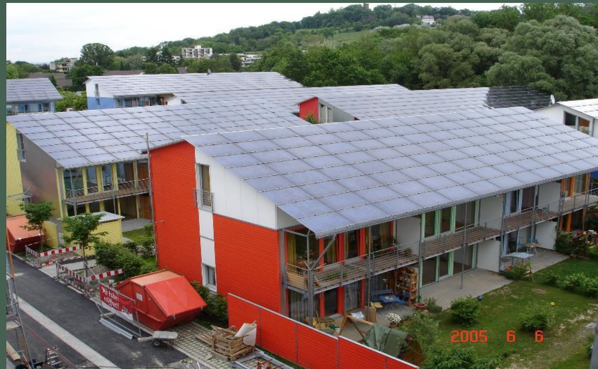
▶ プラスエネルギー団地 パッシブハウスとソーラーエネルギー
